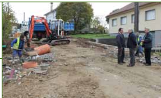
Manuel Mirás e Eduardo Veiras, supervisan as obras no Cruceiro
