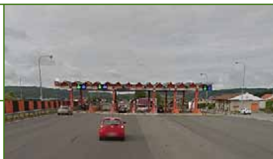
O Concello vén de rematar un investimento de 48.798 en estradas
