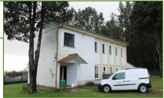
As actuacións de mellora céntranse no interior da segunda planta do inmoble
