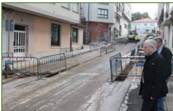
M. Mirás e E. Veiras supervisan as obras
