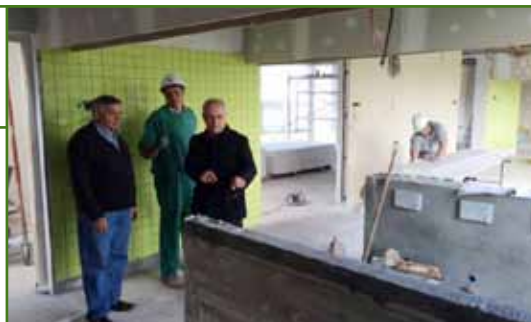
Manuel Mirás e Eduardo Veiras, moi satisfeitos coa marcha das obras
