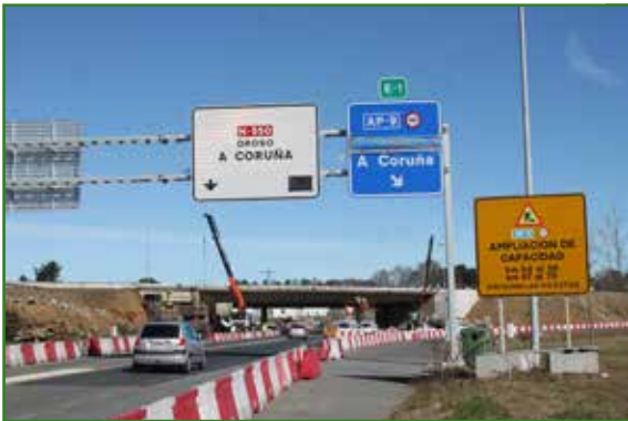
Retomadas as obras da ponte sobre a N-550
